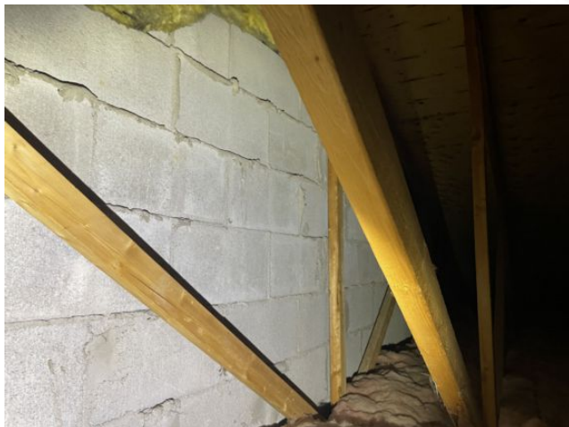
Mur en bloc de béton aux combles
