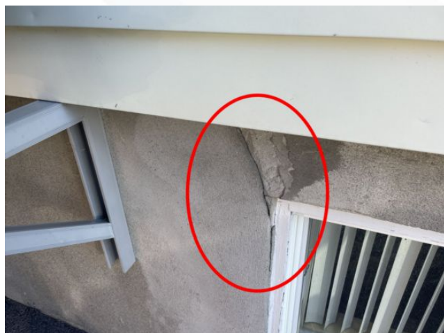
[Façade gauche du bâtiment]
