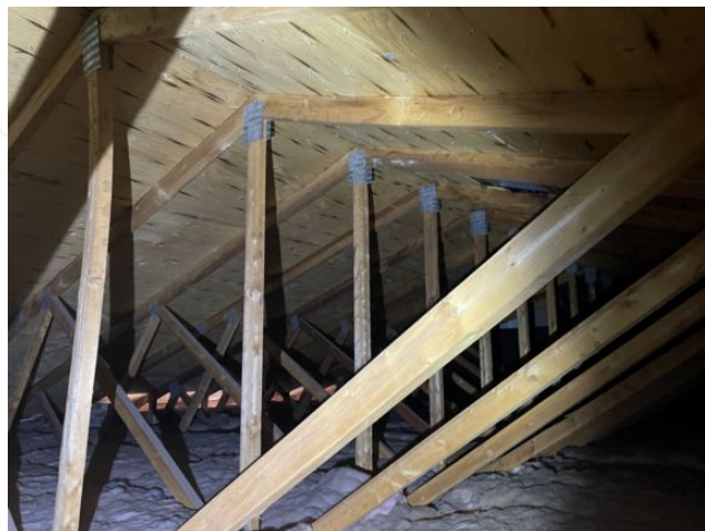
Aucune déficience observée sur la ventilation du toit
