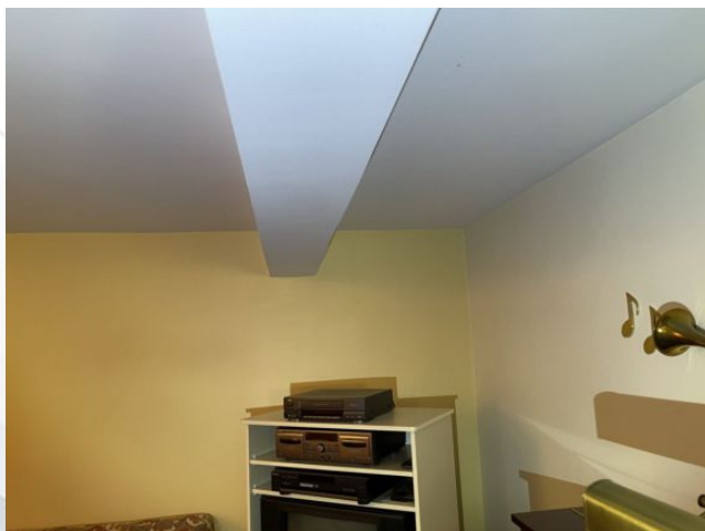
Revêtement de finition cachant la poutre centrale
