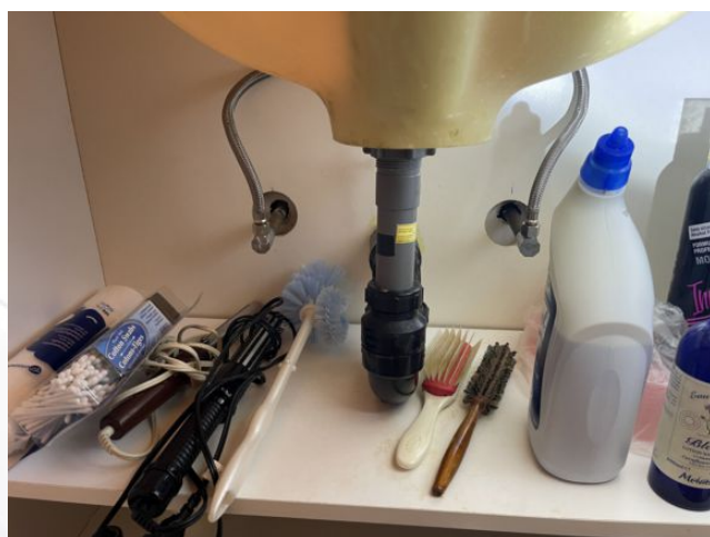
[Salle de bain du rez-de-chaussée]
