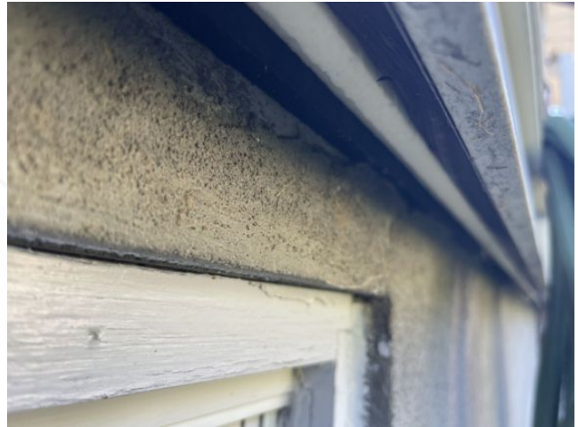
[Façade arrière du bâtiment]
