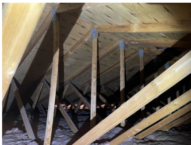
Fermes de toit préfabriquées
