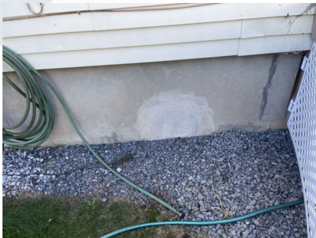
[Façade arrière du bâtiment]
