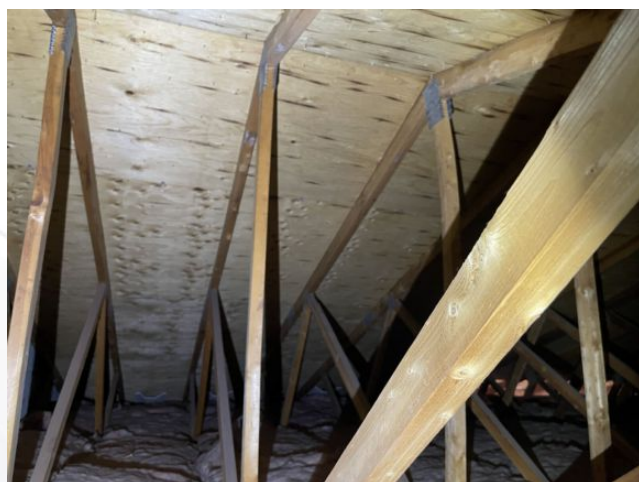
Platelage du toit en contreplaqué
