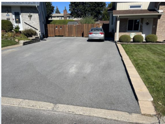
Entrée de stationnement sans déficience significative
