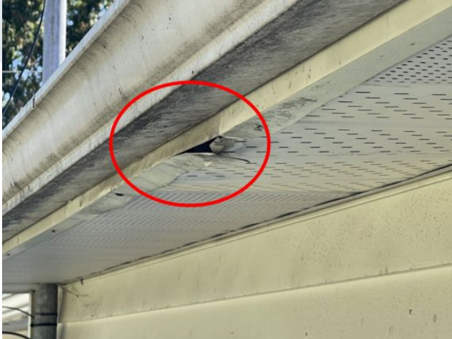
Ouvertures à sceller [Façade arrière du bâtiment]
