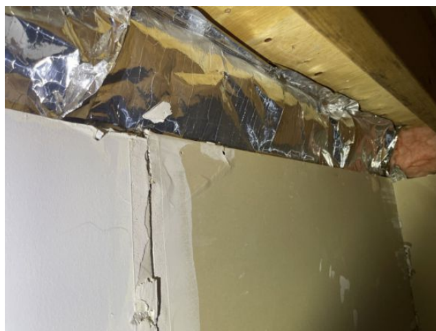
Présence d'un pare-vapeur en aluminium sous la surface du revêtement de gypse
