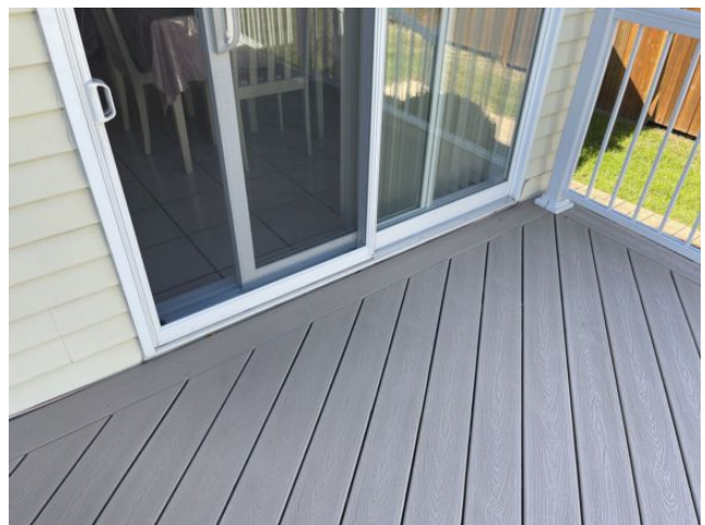
Porte patio appuyée sur la terrasse
