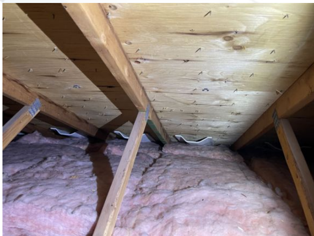
Défecteur de type "Styrovent "
