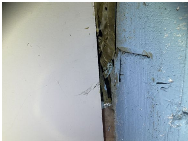
Section visible de l'isolant au sous-sol
