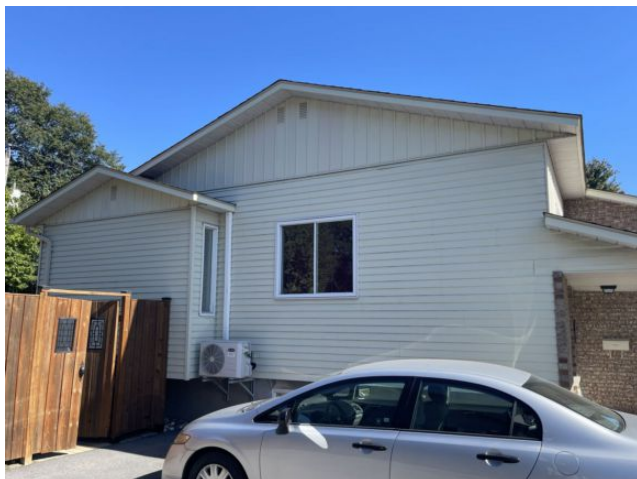
[Façade gauche du bâtiment]
