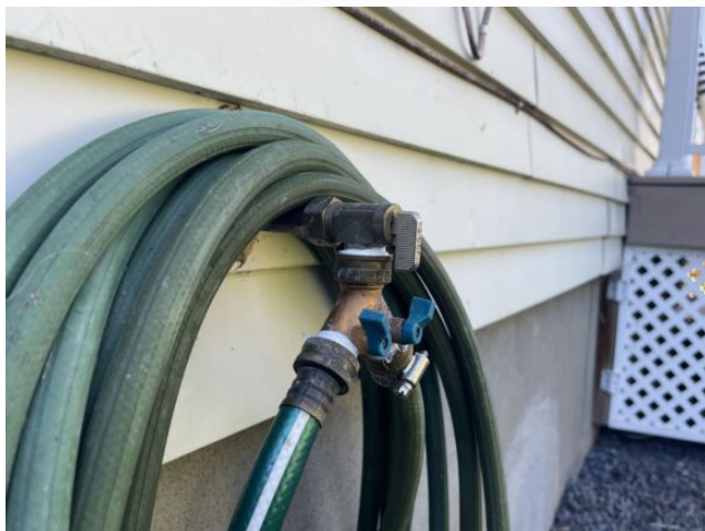
Valve d'arrêt du robinet extérieur
