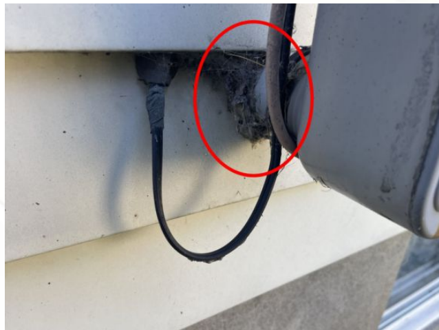
Ouverture du conduit de l'entrée électrique à sceller [Coin droit de la façade arrière du bâtiment]
