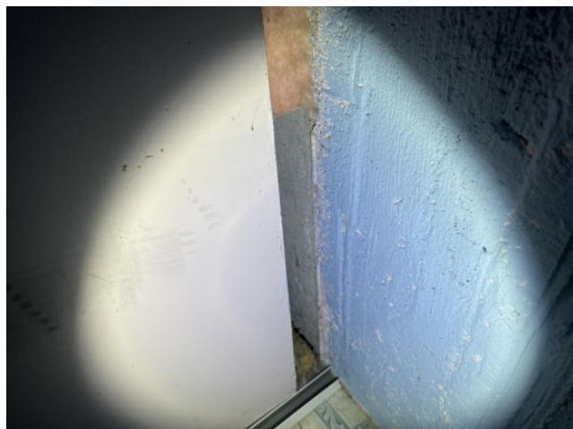
Petite section visible de la fondation
