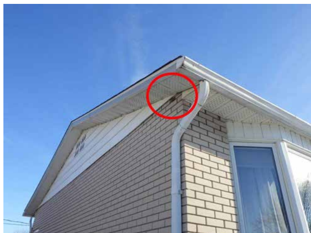
Ouverture dans le revêtement de brique
