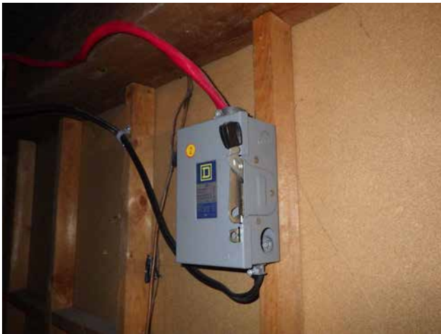
Dispositif d'arrêt de sûreté de la fournaise directement derrière l'appareil
