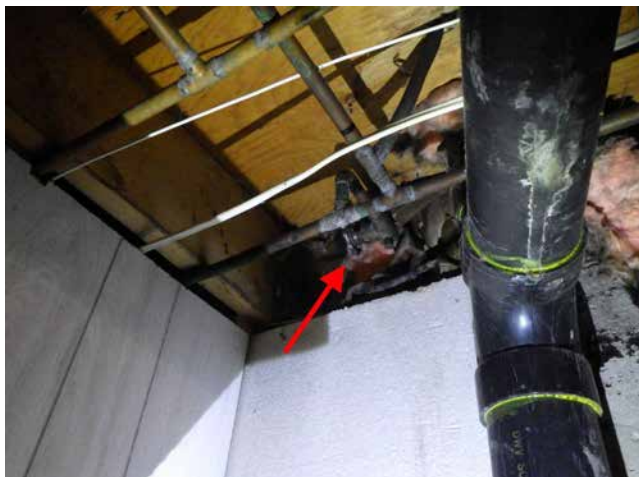
Valve d'arrêt du robinet extérieur
