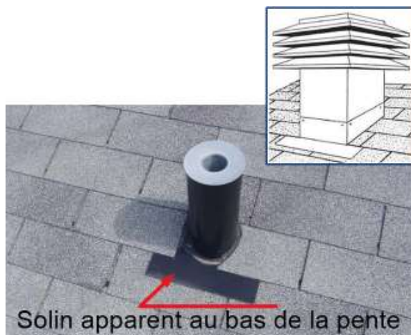
Installation recommandée des solins
