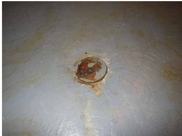
Couvercle non-perforé sur le drain
