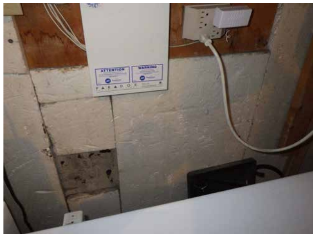
Isolant en Polystyrène expansé non recouvert près de la fournaise
