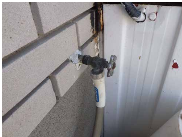
Robinet extérieur sans protection contre le gel
