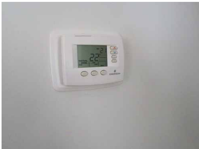
Thermostat contrôlant la fournaise
