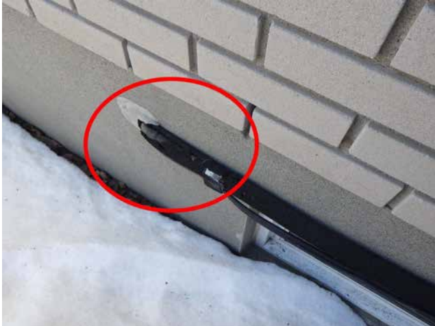
Calfeutrante au pourtour des conduits du climatiseur à refaire
