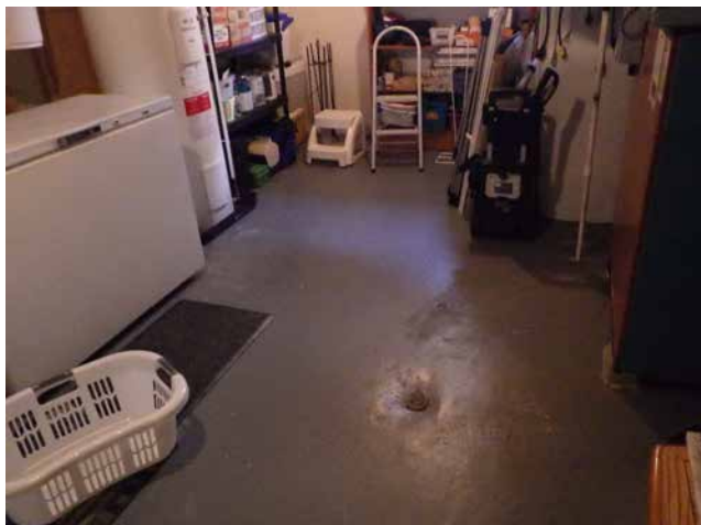
Aucun dommage significatif sur la dalle visible
