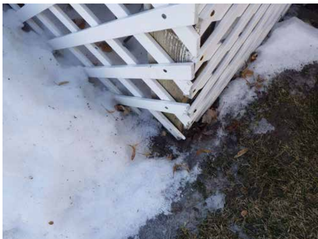
Colonne de bois reposant directement sur le sol
