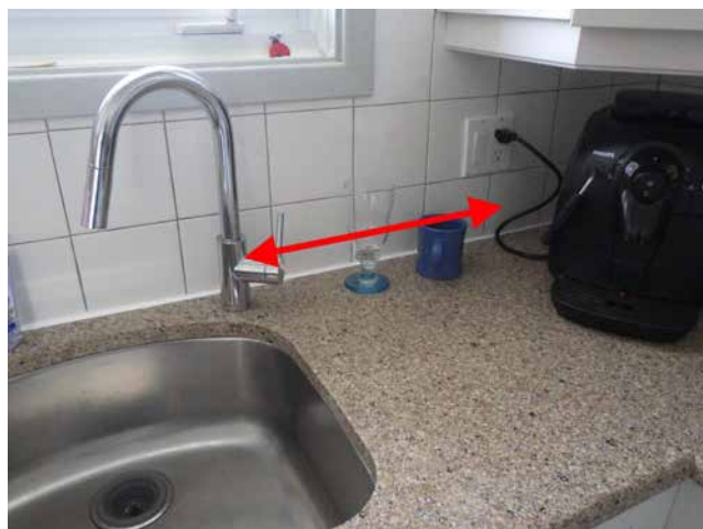
Seconde prise de courant à protéger
