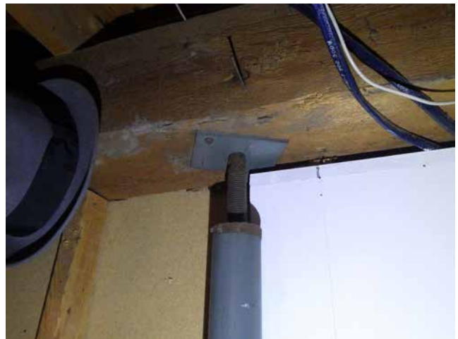
Plaque de soutien de la colonne trop étroite
