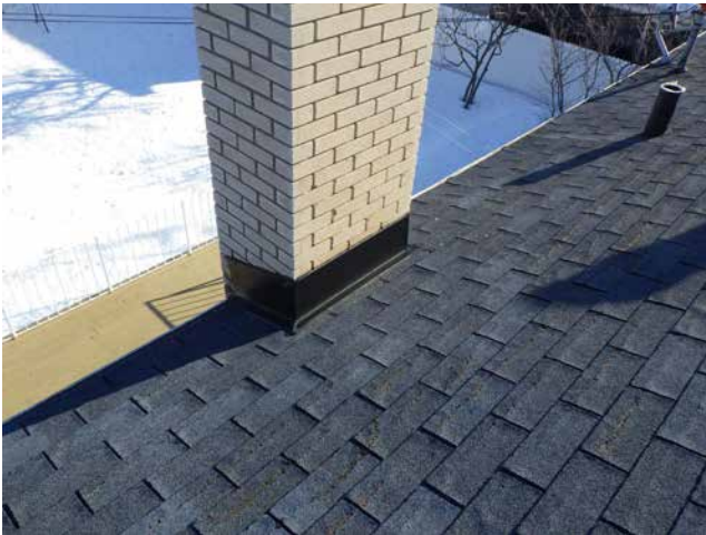
Solin mal installé au pourtour de la cheminée
