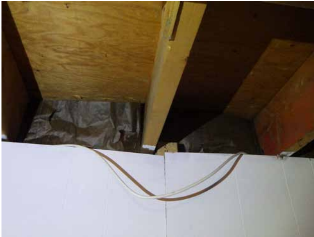
Solive de rive caché par un bouchon de laine isolante
