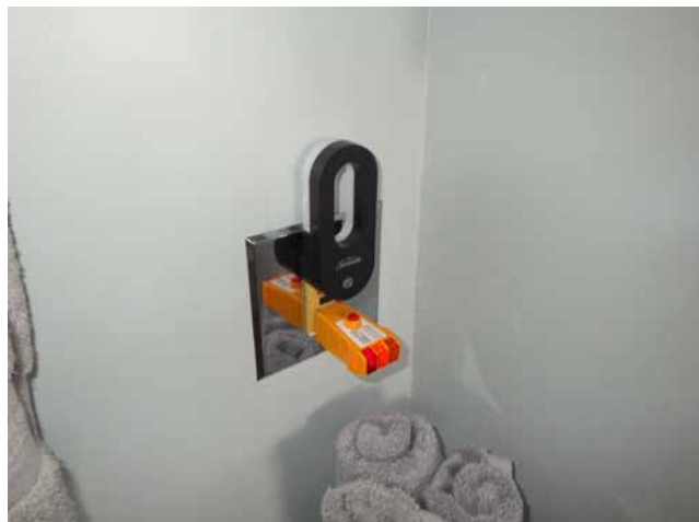
Test de polarité d'une prise de courant [Salle de bain du rez-de-chaussée]
