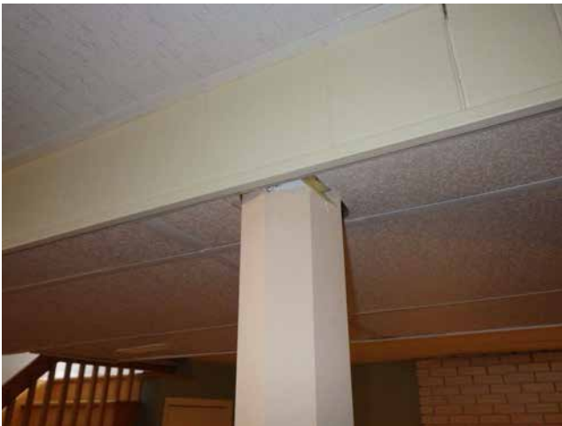
Revêtement de finition cachant la poutre et les colonnes
