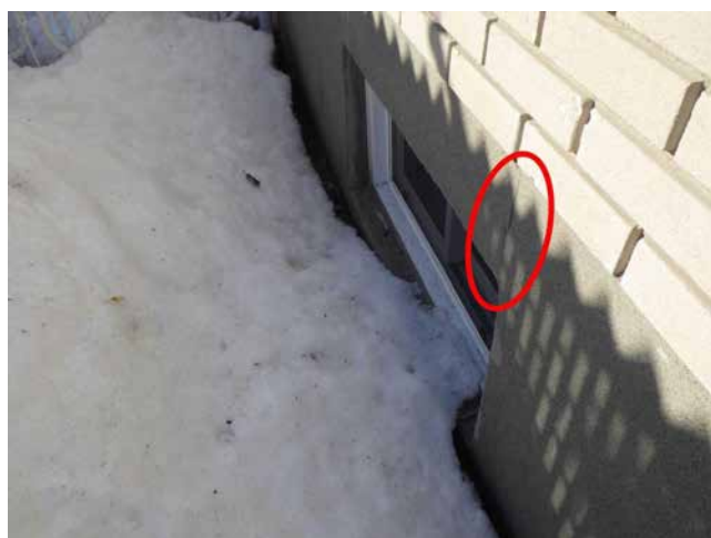
Seconde fissure réparée sur la fondation [Façade droite du bâtiment]
