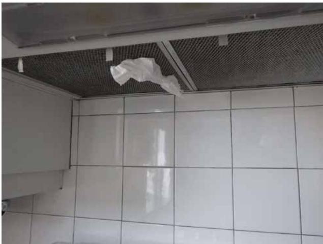
“Test du mouchoir” sur la hotte de la cuisinière
