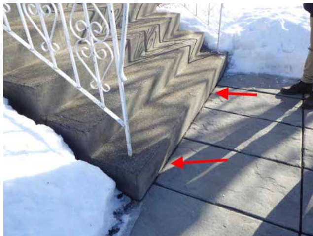
Escalier de béton déposé sur le sol
