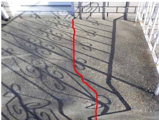
Fissure dans le béton de l'escalier
